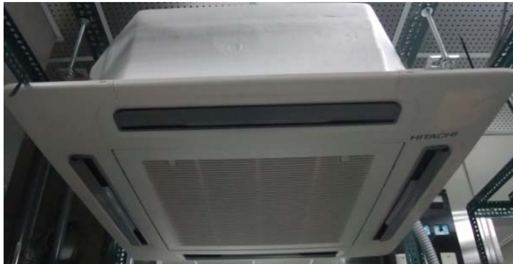
圖 45：多聯式空調機樣品機室內機
