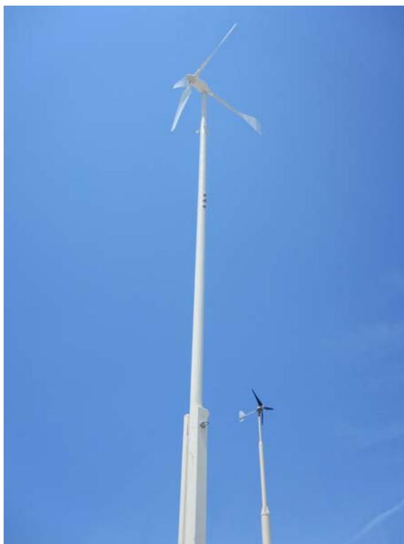
圖 7-2 1.2kW 測試小風機(前)
