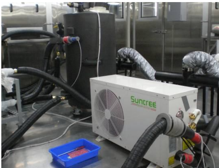
圖 43、熱泵熱水器安裝與測試
