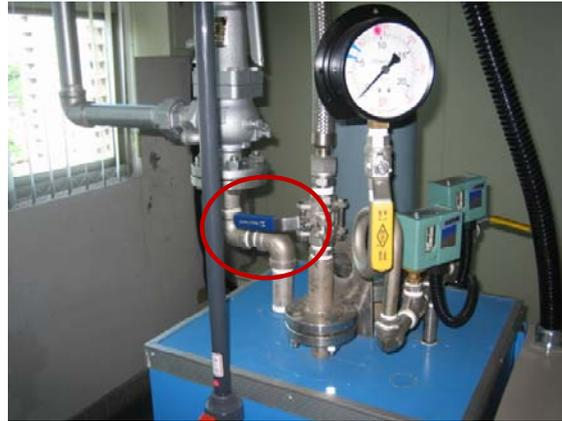
圖 46 蒸氣閥關閉(此圖為 off 狀態)
