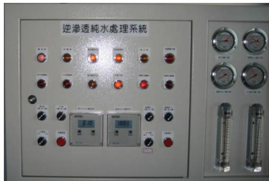
圖 43 逆滲透純水處理系統電源開啟狀態
