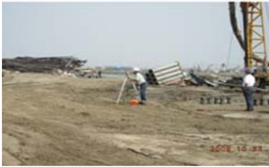
塔位測量及放樣
