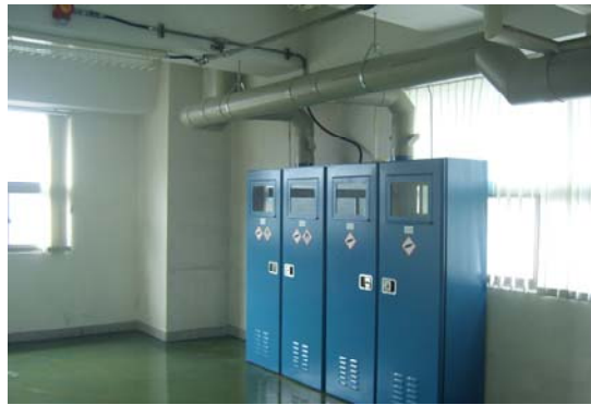
圖 4- 64 基礎環境及測試設備現場建置照片(二)
