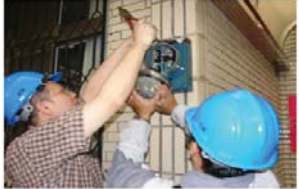
科園社區拆除電表底座脫落
