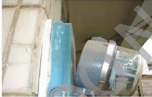
科園社區拆除電表底座脫落
